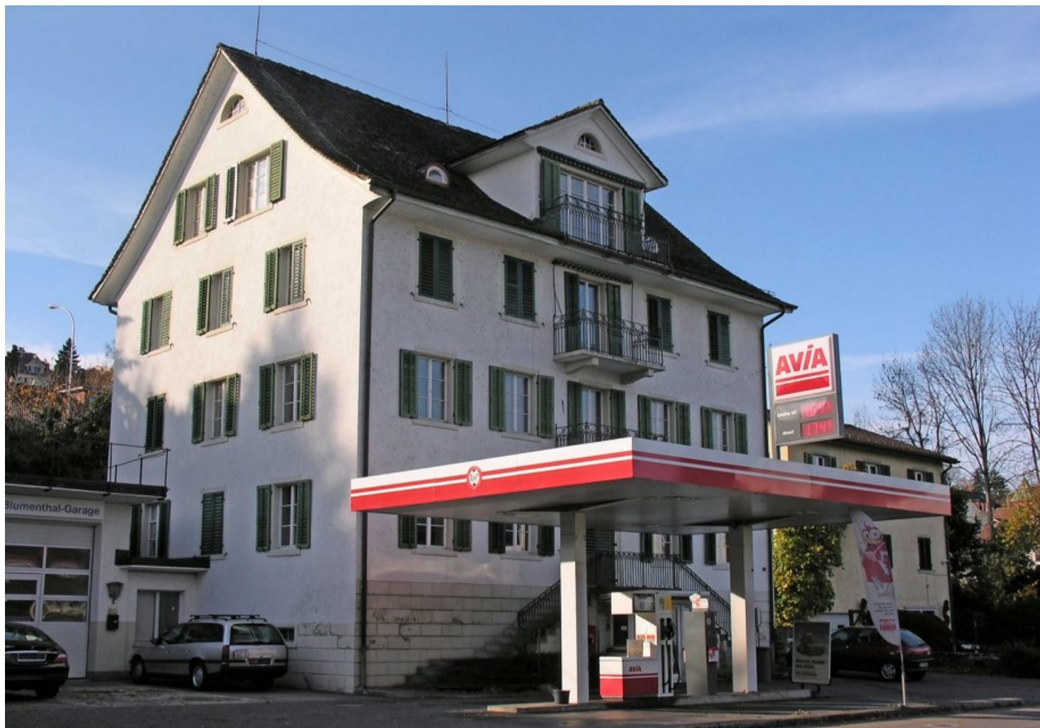
Die denkmalgeschützte Villa Blumenthal (rechts oben) an der Seestrasse in Kilchberg wird samt Kellergeschoss umplatziert. Die Blumenthal-Garage und die Tankstelle neben der Villa (unten) weichen einem Mehrfamilienhaus.
